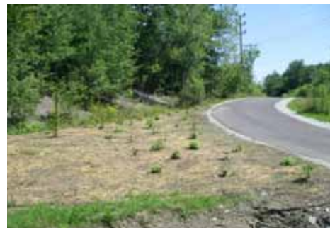
Stabilisation des sols © Destination Sherbrooke
