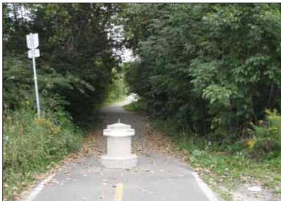
Envahissement de l'aire de circulation © Vélo Québec
