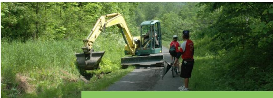
**Figure 12** | *Drainage : profilage de fossé*
