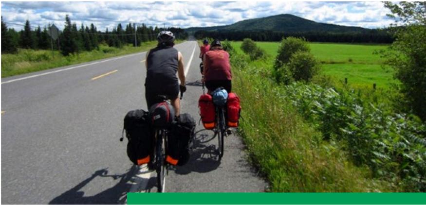
**Figure 5** | *Accotement asphalté*
