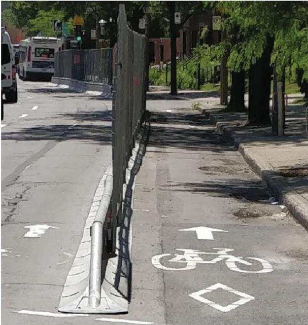
Les glissières de sécurité en acier de type MiniGuard peuvent être utilisées sur les chantiers ou pour l'installation de voies cyclables temporaires. Elles offrent une flexibilité permettant d'adapter leur configuration selon les phases changeantes d'un chantier. Surmontées d'une clôture, elles permettent de contrôler le passage des piétons.
