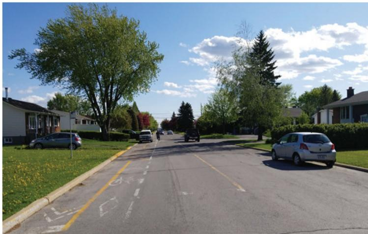
*Figure 2 - Piste bidirectionnelle sans séparation physique avec un arrêt d'autobus*
