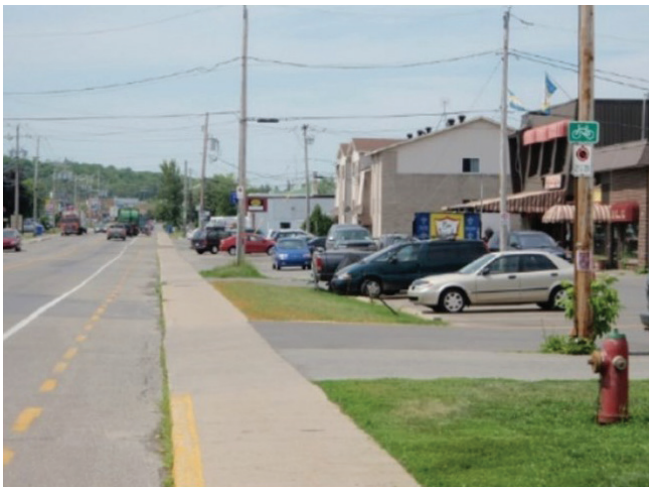
Figure 8 : Figure 6 – Exemple de conversion d'une piste bidirectionnelle sur rue en bandes cyclables unidirectionnelle - Grand Boulevard, Île Perrot
