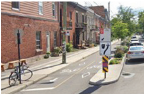
Figure 11 – Pistes bidirectionnelles sur rue séparées par une bordure de béton | Google Streetview
