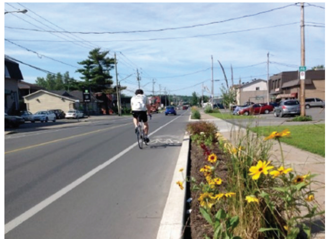
Figure 8 : Figure 6 – Exemple de conversion d'une piste bidirectionnelle sur rue en bandes cyclables unidirectionnelle - Grand Boulevard, Île Perrot
